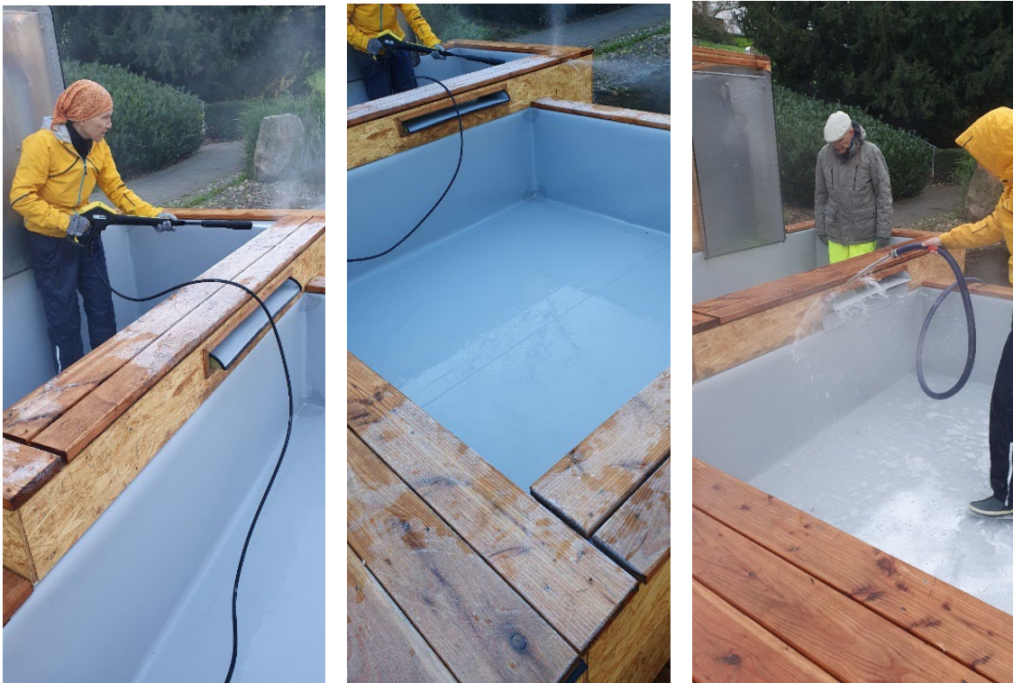
Abb. 8: Reinigungsarbeiten am Wärm Komp 05.11.2024 und 06.12.2024 (thermische Desinfektion) (Fotos: Initiative Wärm Komp)
