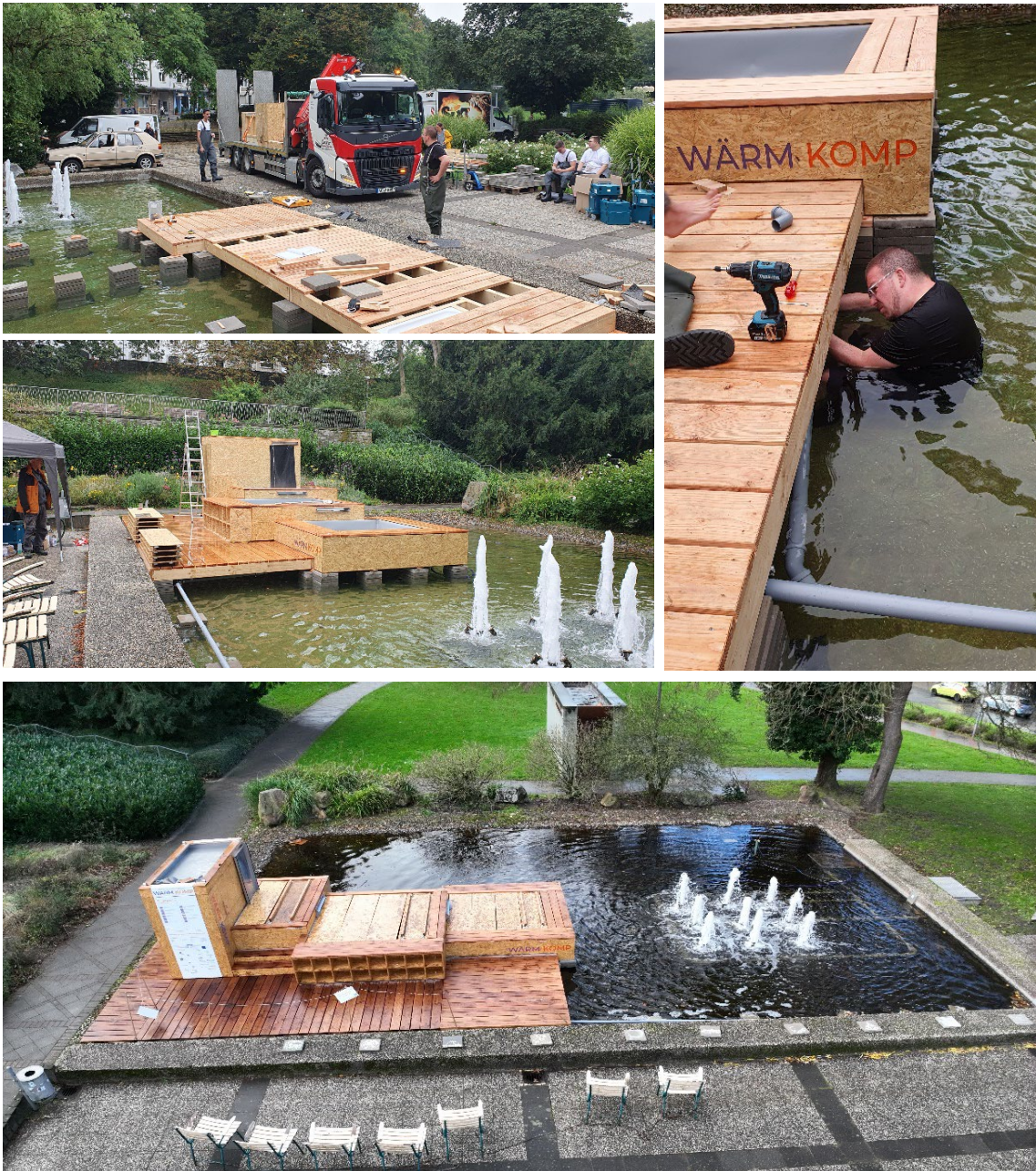
Abb. 5: Aufbau des Wärm Komp am 04.09.2024 (Terrassenelement, Anlage, Abwasser); unten: Luftbild in geschlossenem Zustand (07.12.2024) (Fotos: Initiative Wärm Komp)
