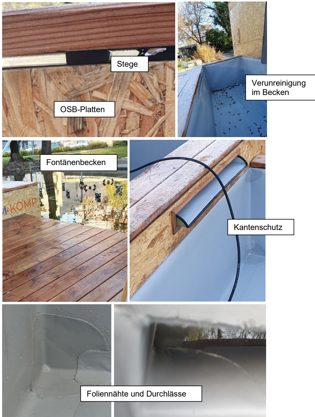
Abb. 11: Schwachstellen des Wärm Komp (Fotos: Ulrich Lieser)
