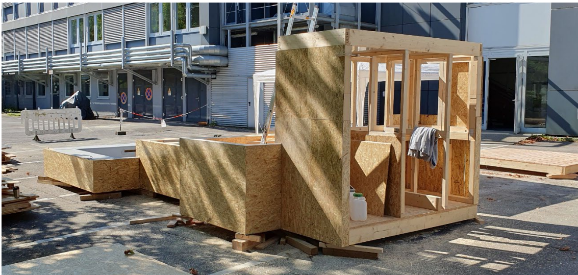
Abb. 3: Anlage im Rohbau an der FH Aachen, Fachbereich Architektur (Foto: Initiative Wärm Komp)
